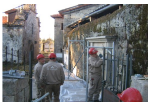
Práctica en el montaje de andamios
